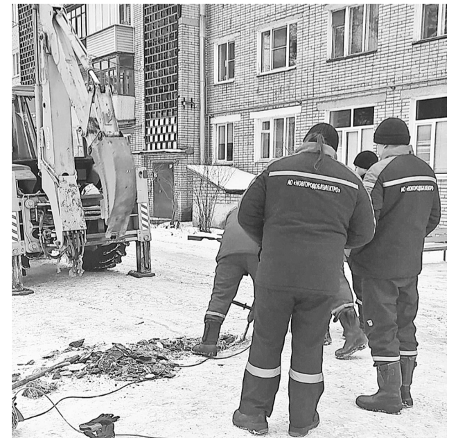
Энергетики устраняют последствия аварии на ул. Боровой
